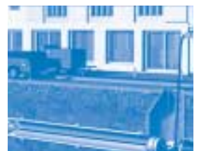
Bis zu 12 UV-Lampen werden von der Kontrollstation im Installations-Lkw aus eingeschaltet und für den Liner-Härtungsprozess durch das Abwasserrohr mit einer exakt ermittelten Geschwindigkeit gezogen. Alle wichtigen qualitätsrelevanten Daten werden mit einem Computer erfasst und aufgezeichnet.
