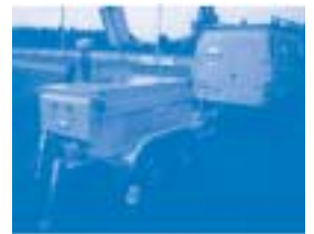
Elektrowinde, die den Liner-Schlauch durch das zu sanierende Abwasserrohr zieht
