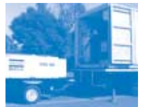
Kompressor zur Erzeugung von Pressluft für das „Aufblasen“ der Liner-Schläuche
